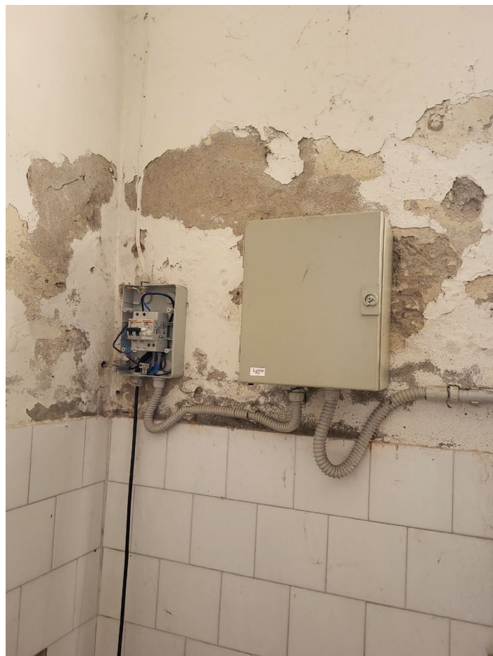
Figura 5 - quadro di zona sostituire QZ01
